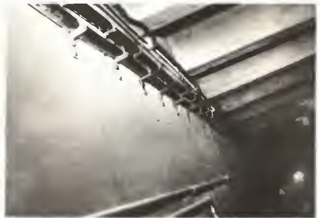
Montaje de dos cables con aislamiento termoplástico de 3 \times 350 \text{ mm}^2 , montados sobre soportes reforzados.
