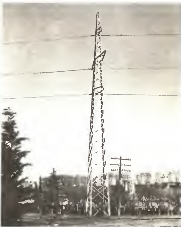
Torre metálica. Preparada para 2 líneas a 25.000 V.
