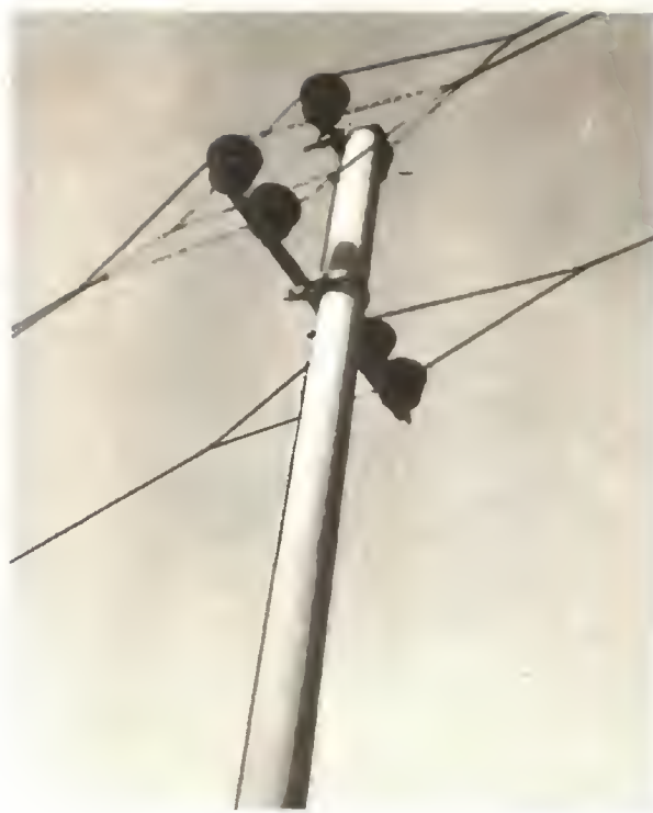
Línea a 25.000 V. montada sobre postes de hormigón.
