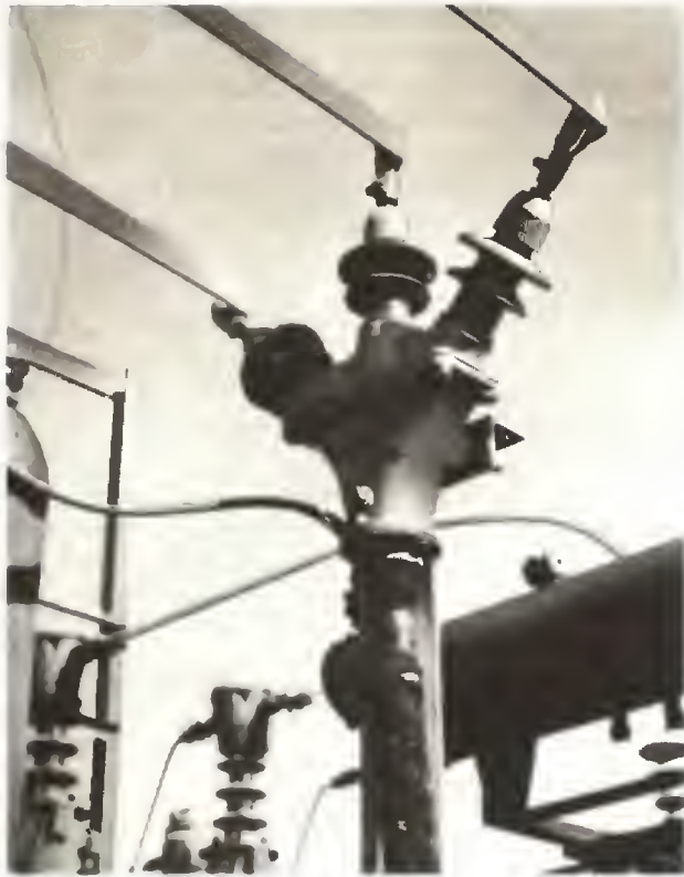
Caja terminal tipo intemperie para cables a 3.000 voltios.
