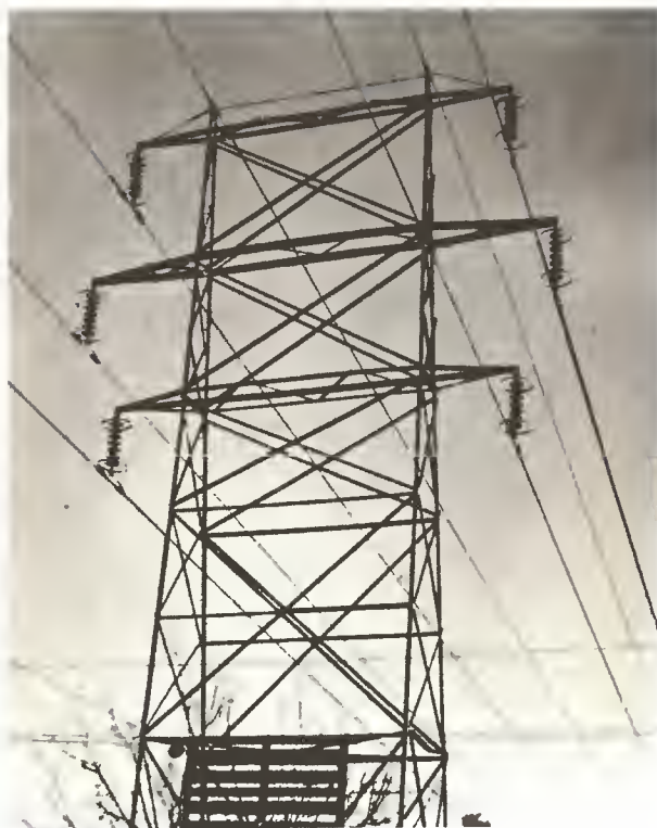
Torre metálica. 2 líneas a 110.000 V.
