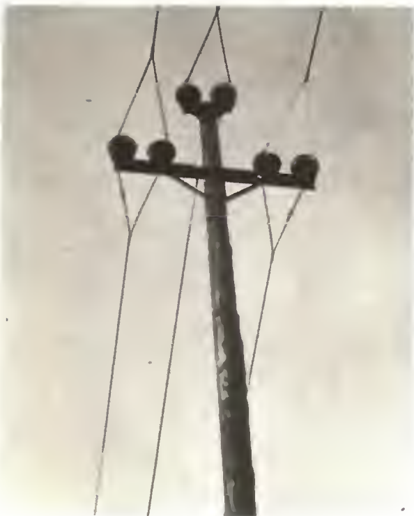
Línea de 25.000 V montada sobre postes de madera.
