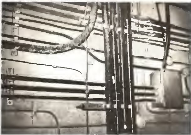
Montaje de cables con aislamiento de papel y cables con aislamiento termoplástico, sobre vías y grapas.
