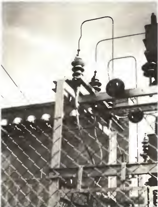
Cajas terminales unipolares, montadas en cable 3 p.omos a 25.000 voltios. Instalación exterior.
