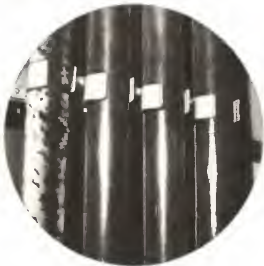
Montaje de cables con aislamiento de papel y cables con aislamiento termoplástico, sobre vías y grapas.
