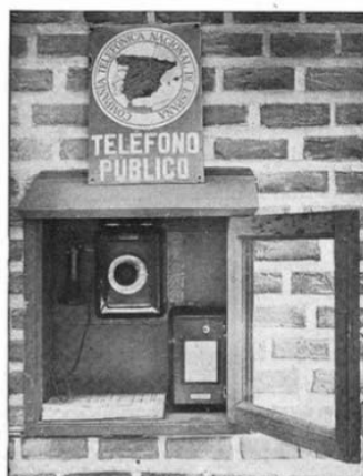
Estación de previo pago instalada en «Vieta Park» (Retiro), y que por hallarse al aire libre está encerrada en una vitrina
