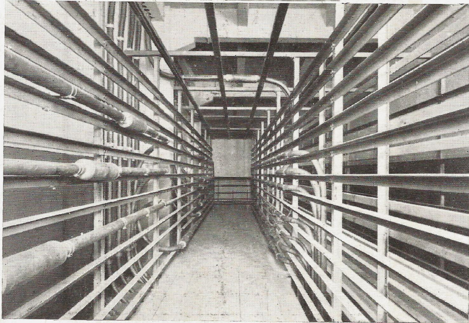
Hoy Entrada de cables en la central de la plaza de Cataluña, por el paseo de Gracia
