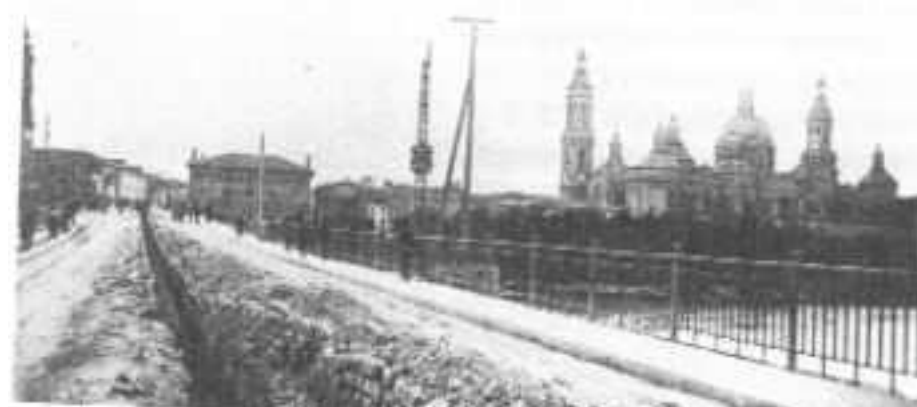
Zanja para pasar los cables en el Puente de Piedra
