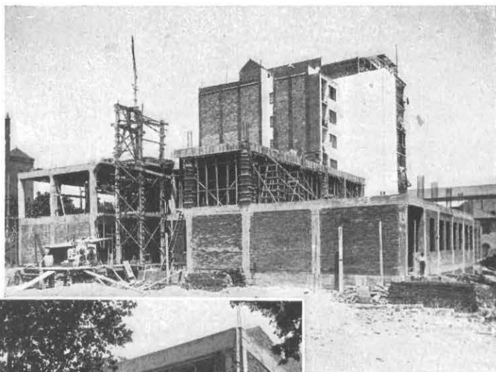
Barcelona: Edificio de la futura central automática del Clot, en período de construcción
