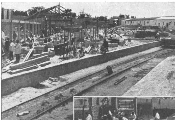
Madrid: Un verdadero ejército de canteros se ocupa en labrar la piedra que ha de recubrir el edificio de la Compañía en la Avenida de Pi y Margall
