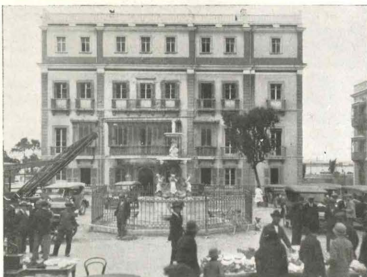
Ayuntamiento de Gibraltar. — La Central automática ocupa el último piso
