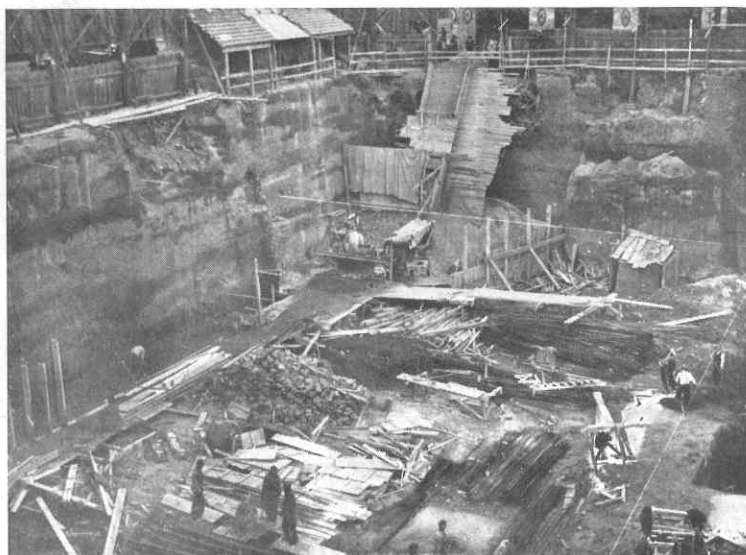
Diciembre de 1926.—Comienzo de los trabajos de cimentación de zapatas. La obra toma un aspecto de redoblada actividad
