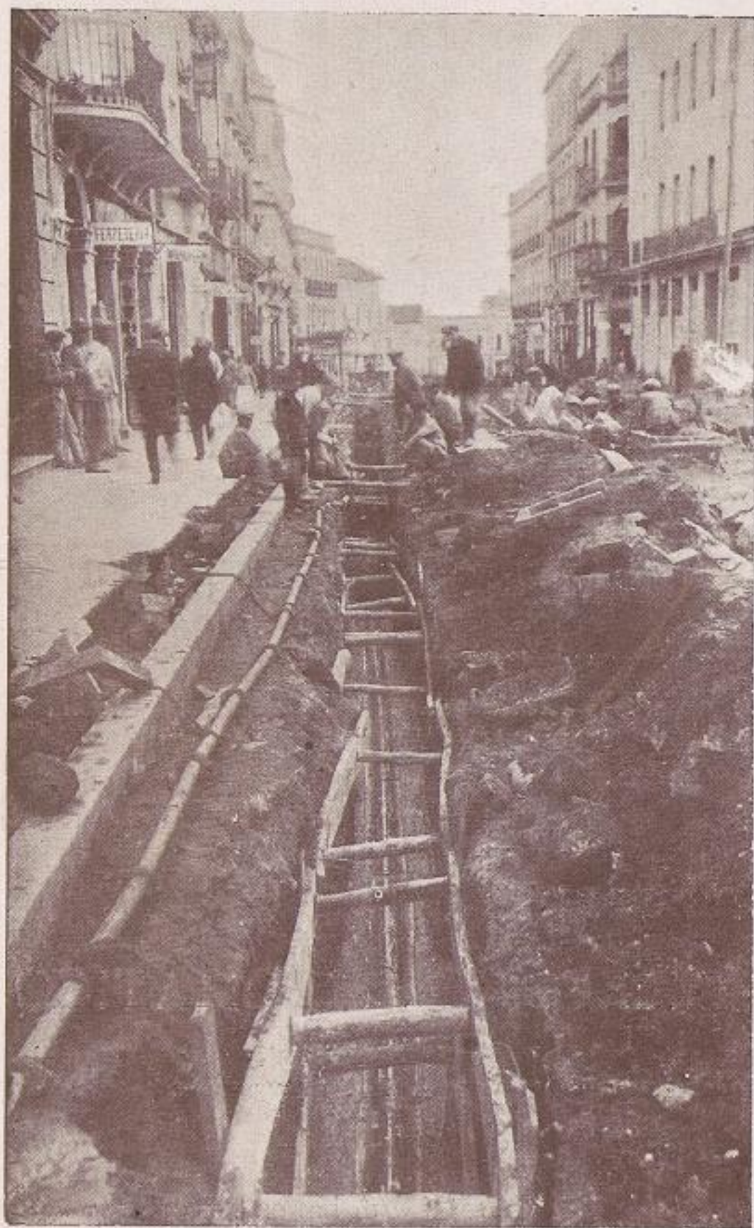
Vista de una calle cordobesa durante la canalización preparatoria del servicio automático
