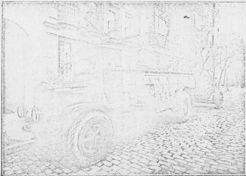
Remolque soportando una bobina de cable de plomo que se transporta por un camión hasta la cámara-registro para tenderse el cable en la canalización subterránea en la calle.
