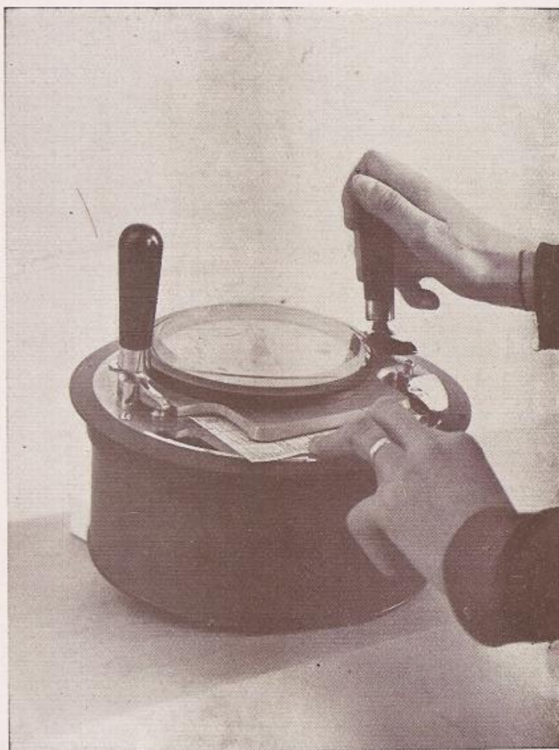
Fig. 2. — Momento de conectarse la conferencia. Por este movimiento hacia adelante de la palanca de la derecha se imprime en el reverso del ticket la hora del día. El movimiento hacia atrás imprime los dos cuadrantes, en los que después quedará estampada la duración de la conferencia
